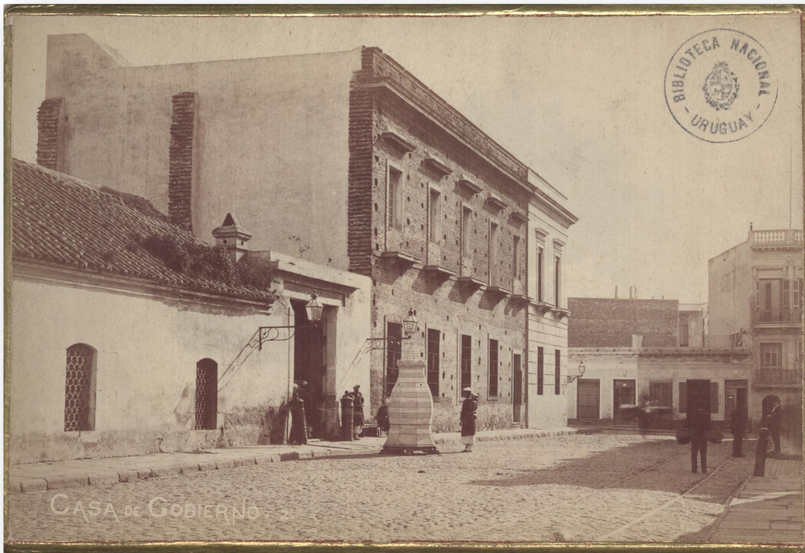
Edificio que ocupó la BNU en 1816
